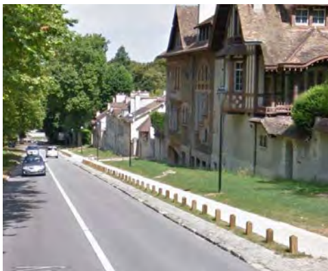
Le réaménagement piétonnier de la route de Marly
